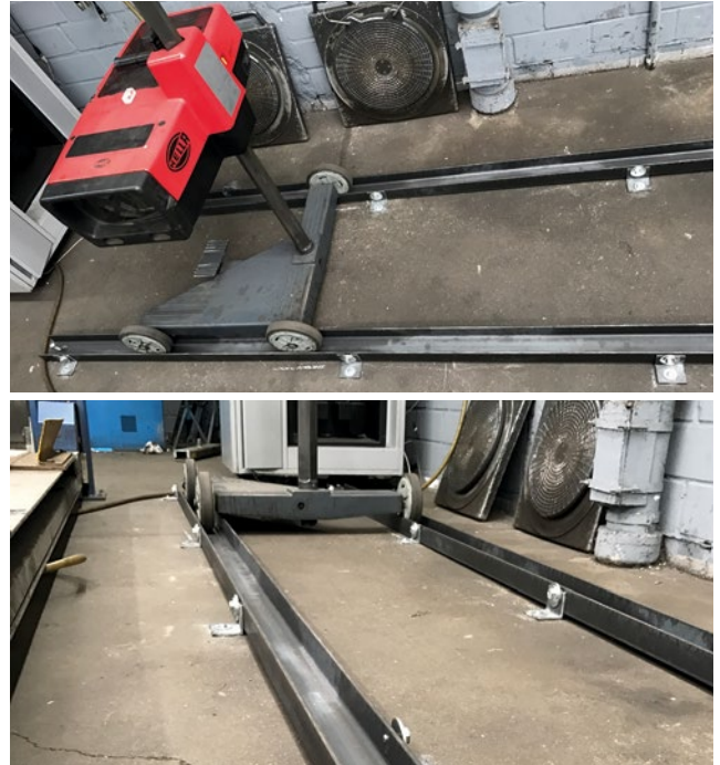
U-Schienen mit Gewinde/Schrauben zur Nivellierung auf dem Boden verlegt und mit Winkeln (Langlöcher nicht vergessen) auf dem Hallenboden verschrauben. (Materialkosten ca. 150 €)
