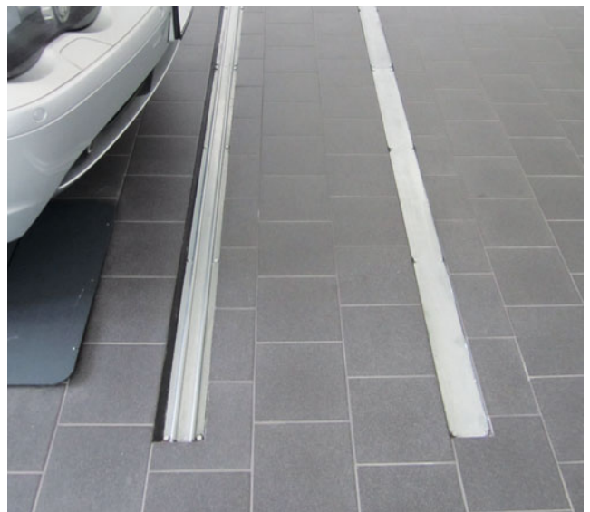
Bild 4: Unterflurschiene (Quelle: Hella: Gutmann Solutions GmbH)
